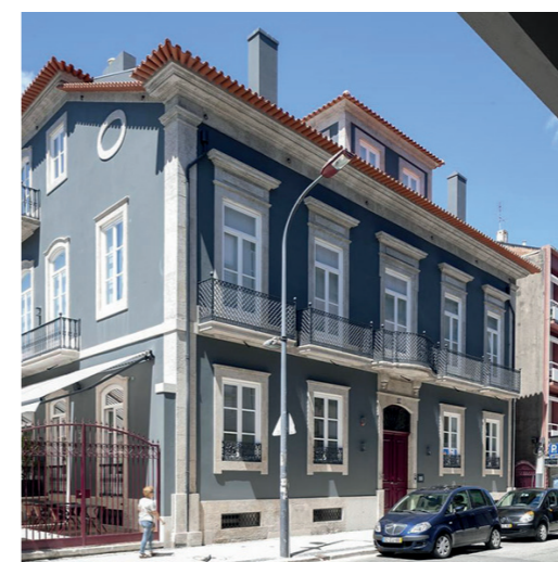
Edifício habitacional - Cedofeita
